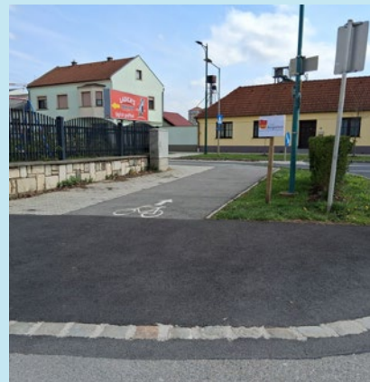
Barrierefreiheit durch Absenkung des Randsteins, Bild: © Gemeinde Parndorf, Trenker
