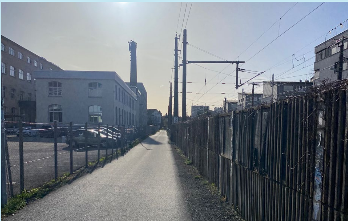
Umgesetzter Rad- und Fußweg entlang der Bahntrasse in Bregenz, Bild: © stadtländ
